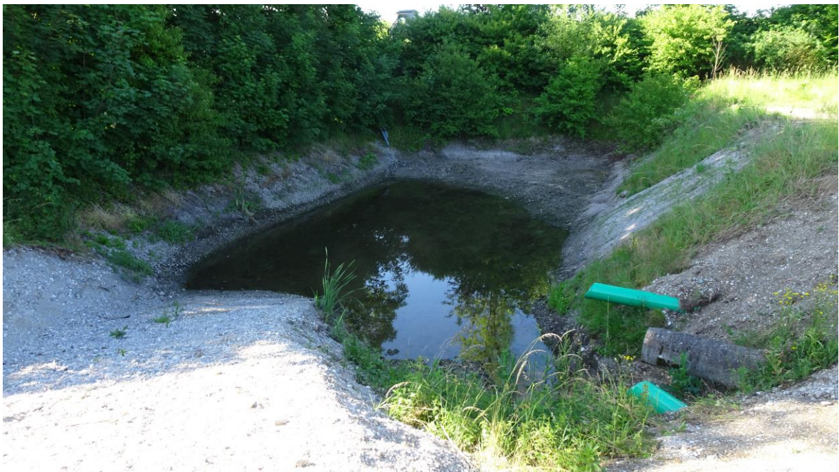
Abb. 9: Versickerungsbecken südlich des Bauernhofs (Foto von Juni 2022, Foto wurde nach einer neuen Rohrverlegung aufgenommen)
