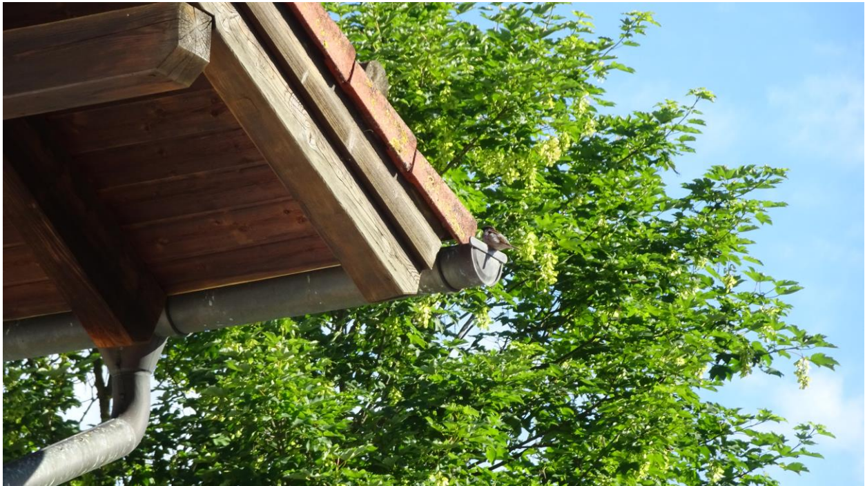
Abb. 11: Haussperling auf dem Dach eines Gebäudes des Bauernhofs.
