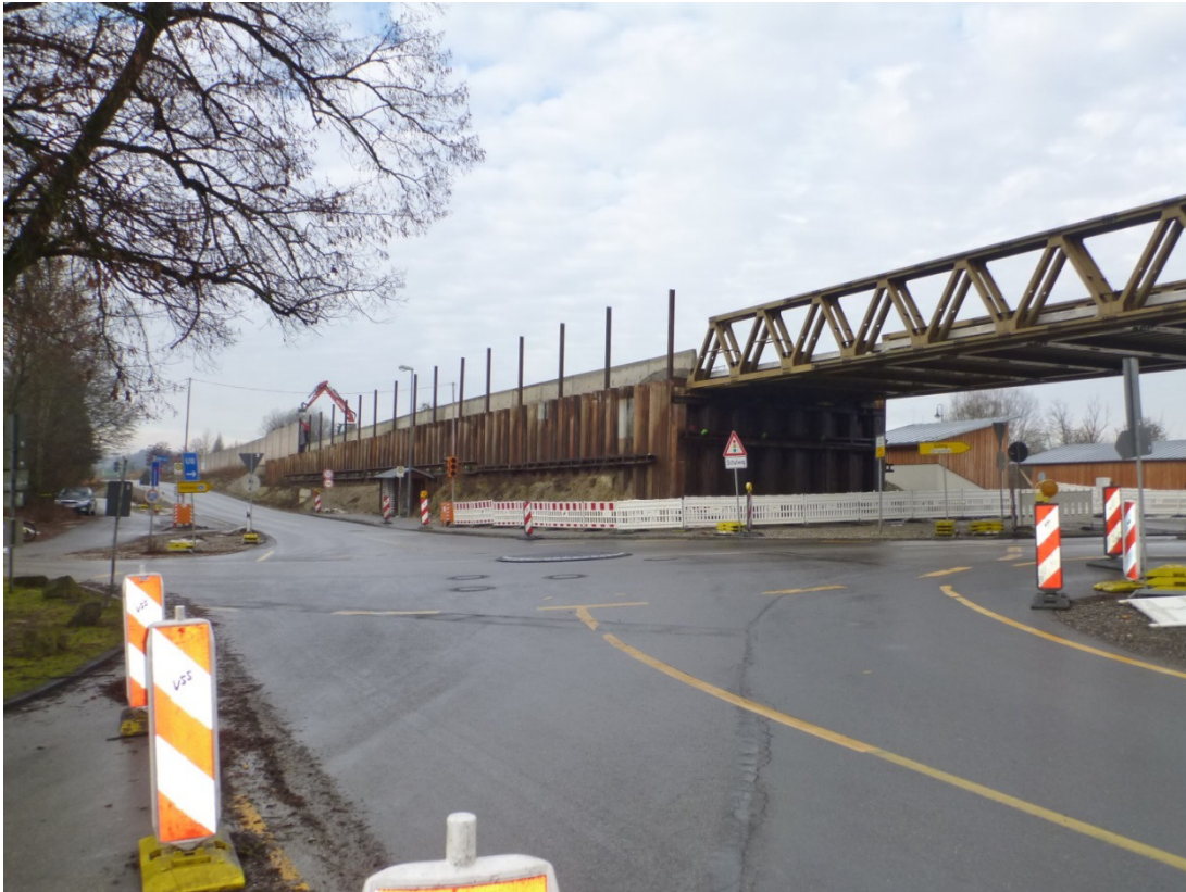
Fotos: Abbau der Lärmschutzwandelemente in Eching und „D-Brücke“, Leonhard Graf
