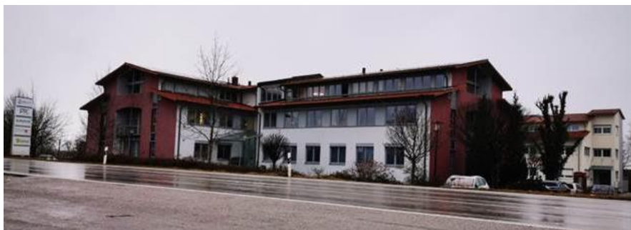
Abb. 3: Gebäude Am Anger 5 nördlich der Staatsstraße
